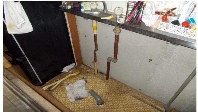
写真は、台所の給水管にピンホールの穴が空いて、階下への漏水があった部屋で、修理は流し台を手前に外して行なわれ、給水管の交換、階下の天井張替と共に、階下の家財被害に対する保険請求などの手続きが行われました。この建物は築30年を超えた鉄筋コンクリート造でファミリータイプ全10室のマンションですが、この部屋以外の部屋でも漏水が発生した事も有り、1階に居住するオーナーは空室となった部屋から、水道管の更新工事の実施を決断されました。更新工事は1室数十万円となる高額工事ですが、その後数年間掛けて全室の工事が完了し、「いつ管が破裂してもおかしくない。排水管洗浄も危険で出来ない」状態を脱しました。空室となった部屋から行った事で、入居者へ負担を掛ける事なく実施出来ました。
